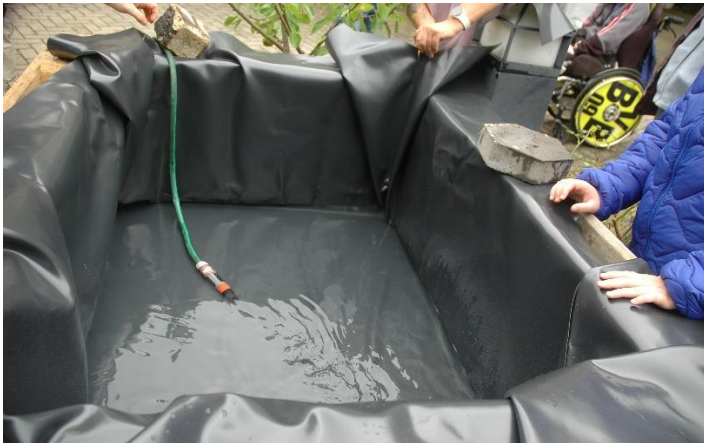
Während des Befüllens die letzten Falten beseitigen und die Ecken legen
